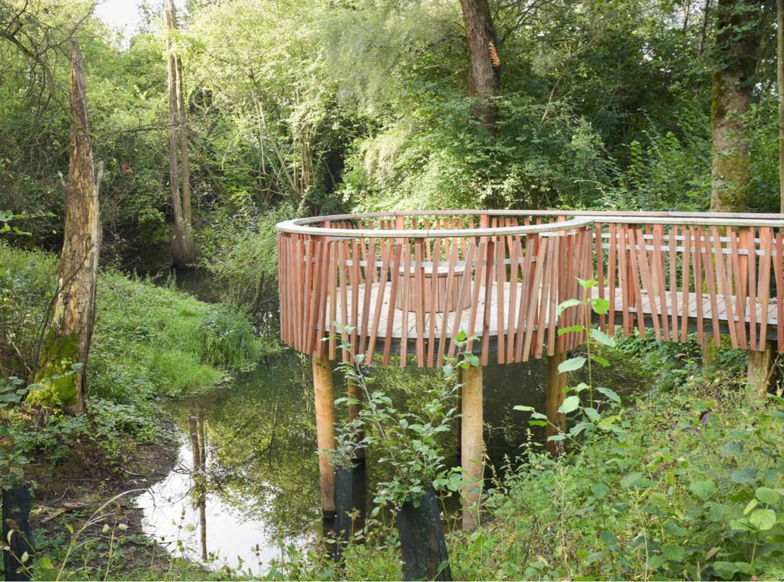
Im Frühjahr wurde die Besucherplattform als «Fenster zur Natur» über der Knopflischlinge errichtet.
