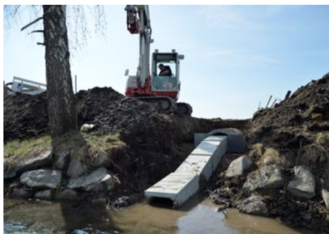
Kunstabau zum Schutz der Strasse.
