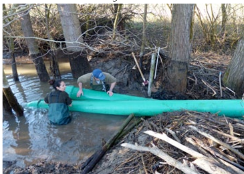
Entlastungsrohre in einem Biberdamm.
